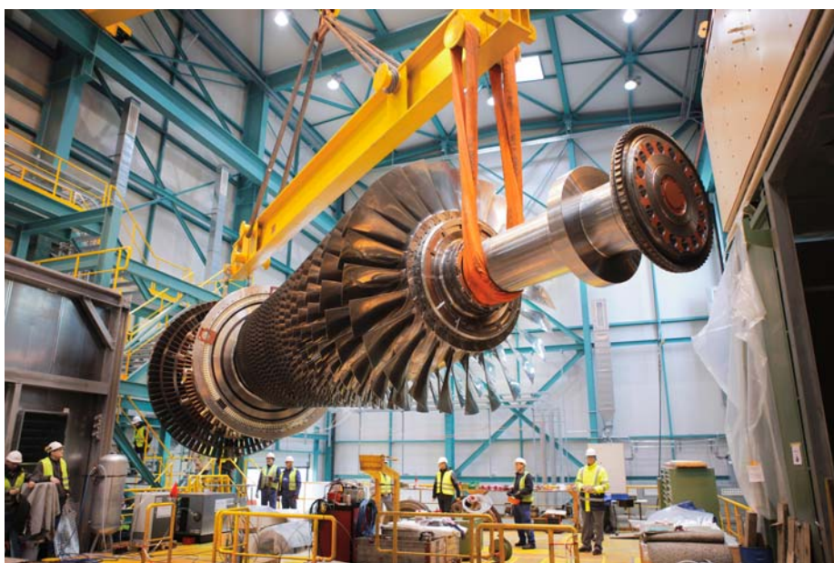
Im Inhouse-Testkraftwerk von Alstom Power in Birr werden Kraftwerkskomponenten unter Feldbedingungen getestet. Der während den Testläufen erzeugte elektrische Strom wird in das Schweizer Stromnetz eingespeist.
